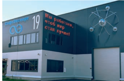
Building facade Фасад здания
