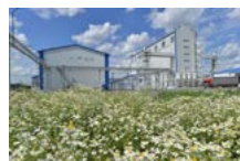
Комбикормовый завод «Пушкинский»
