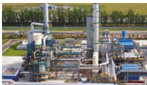
Установка гидроочистки бензина производительностью 750 тыс. тонн в год на ОАО «Славнефть-Ярославнефтеоргсинтез» — построена «под ключ» — 2003 год
