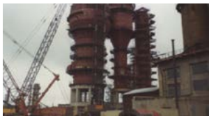
Реконструкция установки каталитического крекинга 1А/1М на ОАО «Рязанский НПЗ-ТНК», изготовление, поставка и монтаж оборудования — 2001 год
