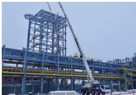
Строительно-монтажные работы ОАО «Челябинский Цинковый Завод»
