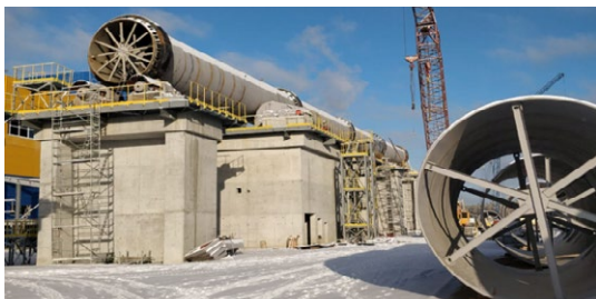
Монтаж печи в г. Сысерть
