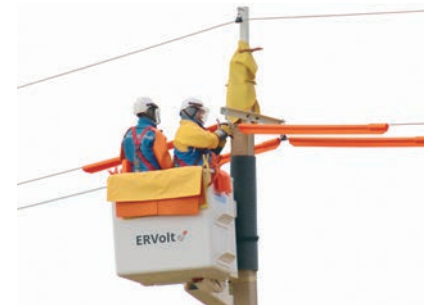
Live-line working on 10 kV overhead lines Работы под напряжением на ВЛ 10кВ
