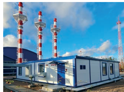
Self-supporting chimneys for a new 9 MW modular boiler plant. Самонесущие дымовые трубы для новой блочно-модульной котельной (БМК) 9 МВт.
