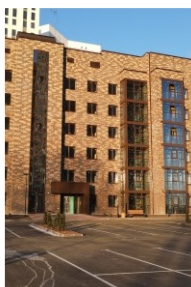
Многоквартирный жилой дом по ул. Новгородская, 10, г. Тюмени
