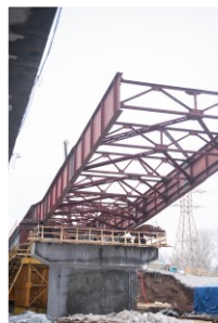
Мостовой переход через реку Сакмара (верхового) на проспекте Братьев Коростелевых, г. Оренбург
