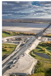
Мостовой переход через реку Обь, г. Сургут
