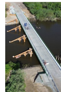
Мост через р.Тобол на автомобильной дороге Нагорное – Утятское, Притобольный район Курганской области
