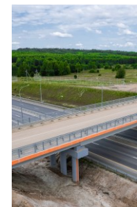
28 искусственных сооружений на автомобильной дороге Дюртюли - Ачит
