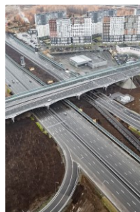
Транспортная развязка на примыкании съезда к спортивному комплексу «Тюмень-Арена» к автомобильной дороге федерального значения «Екатеринбург-Тюмень», г. Тюмень
