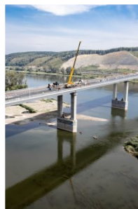
Мост через реку Томь обход г. Кемерово
