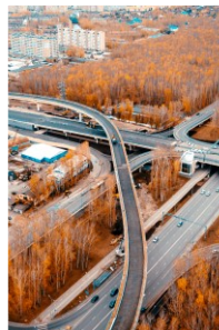
Транспортная развязка в трех уровнях на пересечении ул. Мельникайте – ул. Дружбы
