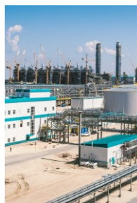
Новый комплекс производства пропилена дегидрированием пропана и деривативов пропилена (ДГП-2), г. Тобольск
