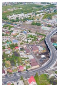
Путепровод через железную дорогу «Москва – Владивосток», г. Ялуторовск
