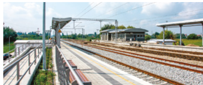
Станица Крњача после реконструкције / Станица Крњача после реконструкције
