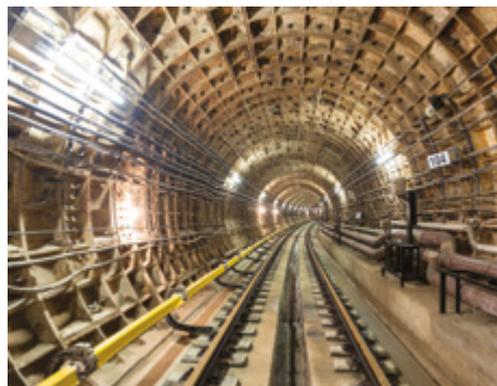
Перегонные тоннели метрополитена
