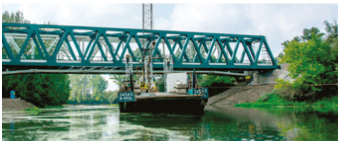
Новый мост через реку Тамиш / Нови мост преко реке Тамиш
